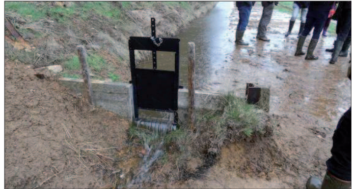
In Cierreux wurde ein Flüxgraben zum Leben erweckt.
