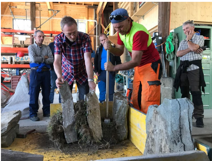
Einführung in den Bau eines Tretschbordes (Foto: Karina Liechti / SL-FP)
